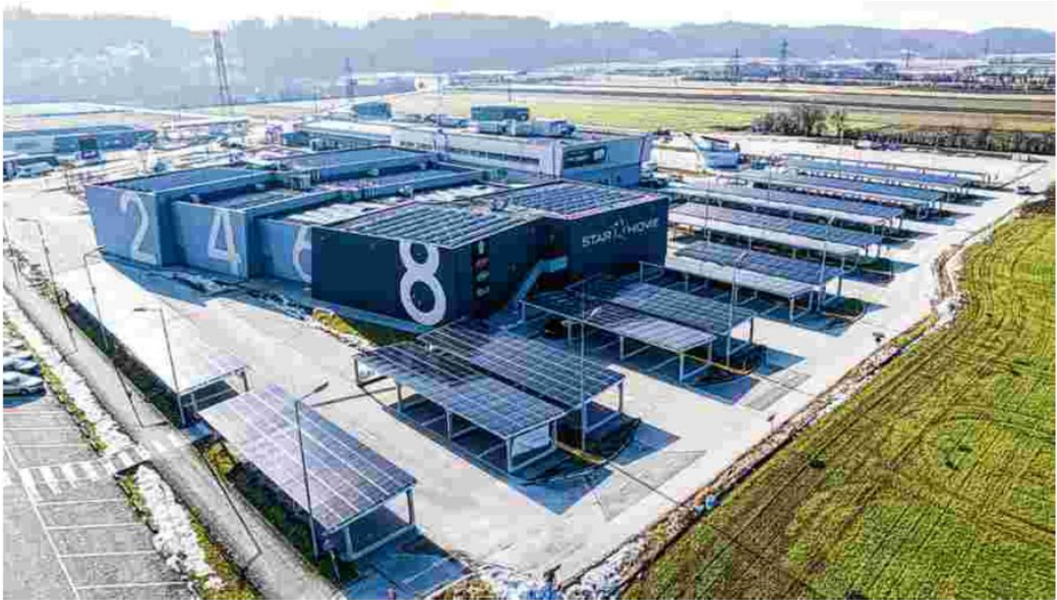
Die überdachten Kinoparkplätze in Regau produzieren Strom für 140 Haushalte.
