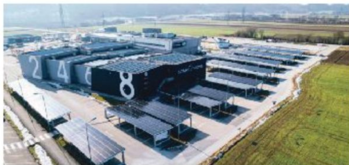
Die PV-Anlage am Star-Movie-Parkplatz produziert die dreifache Menge an Strom, der für das Kinocenter benötigt wird. Foto: Josef Pitschmann/WKA Ökostrom
